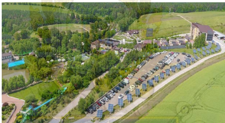
Рисунок 1.3 – Фото зверху локації ЗКВ «Баттерфляй»
